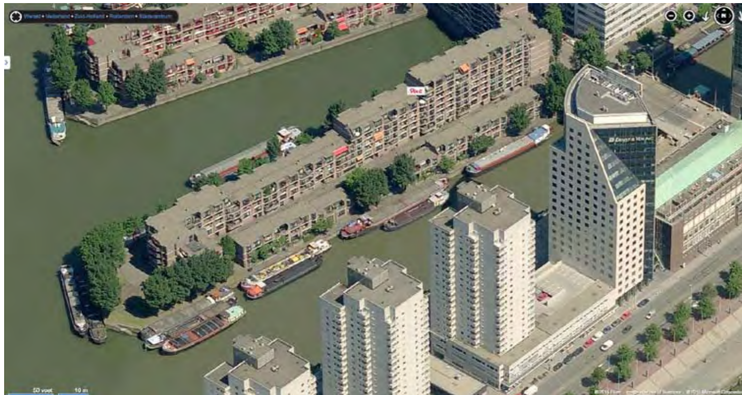
Aanzicht bestaande situatie Noordzijde
