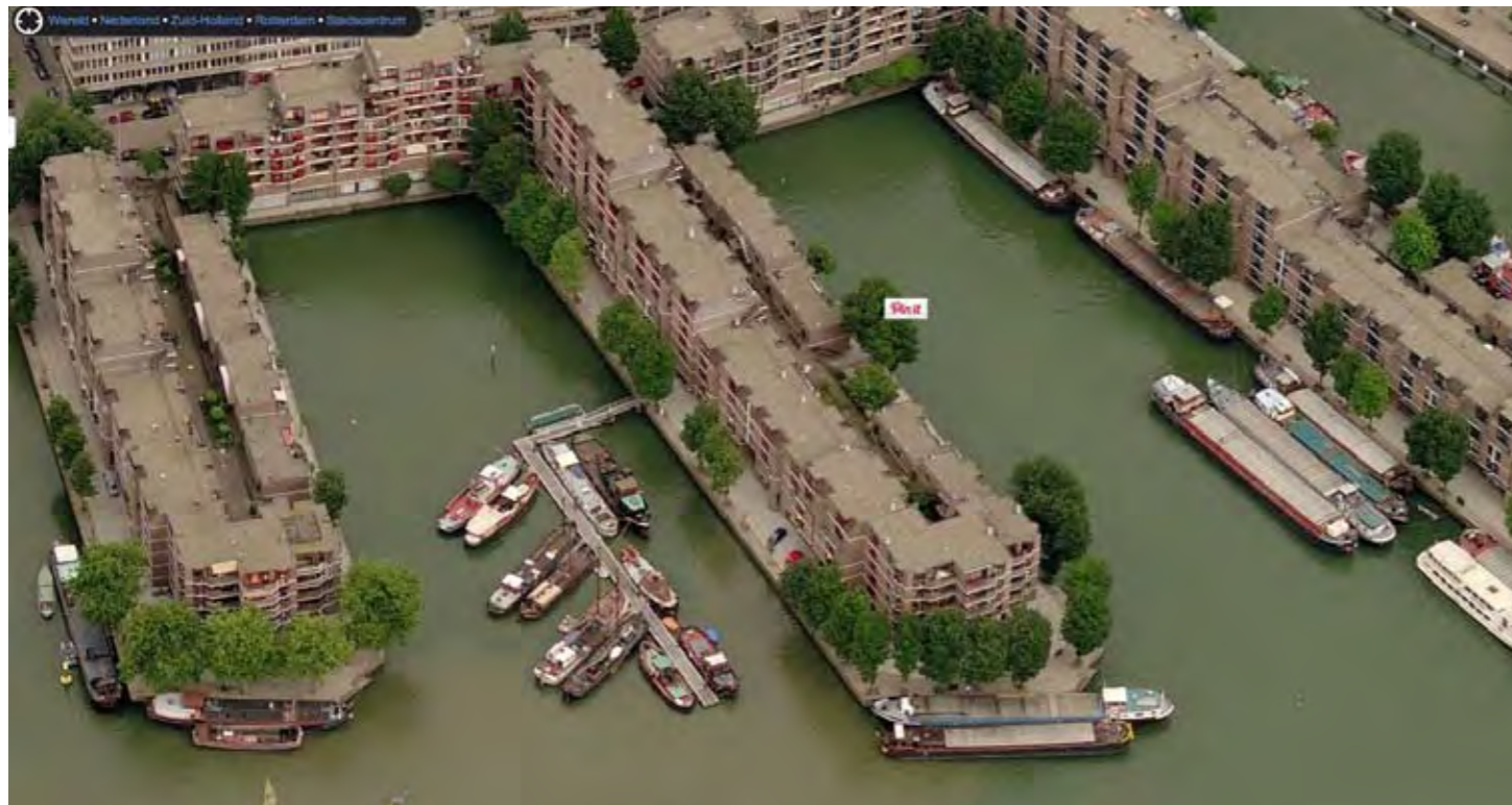
Aanzicht bestaande situatie vanaf west
