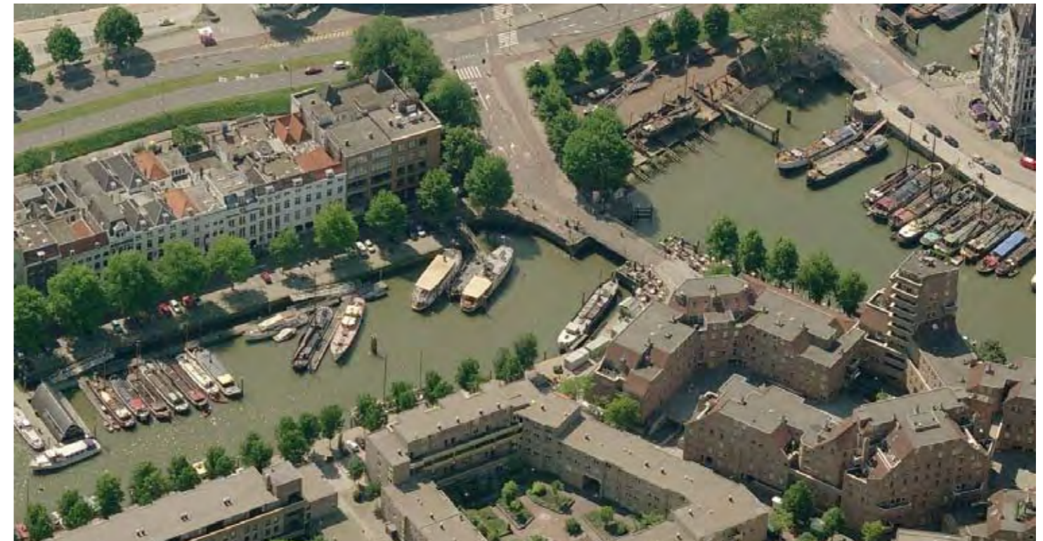
Aanzicht bestaande situatie Noordzijde
