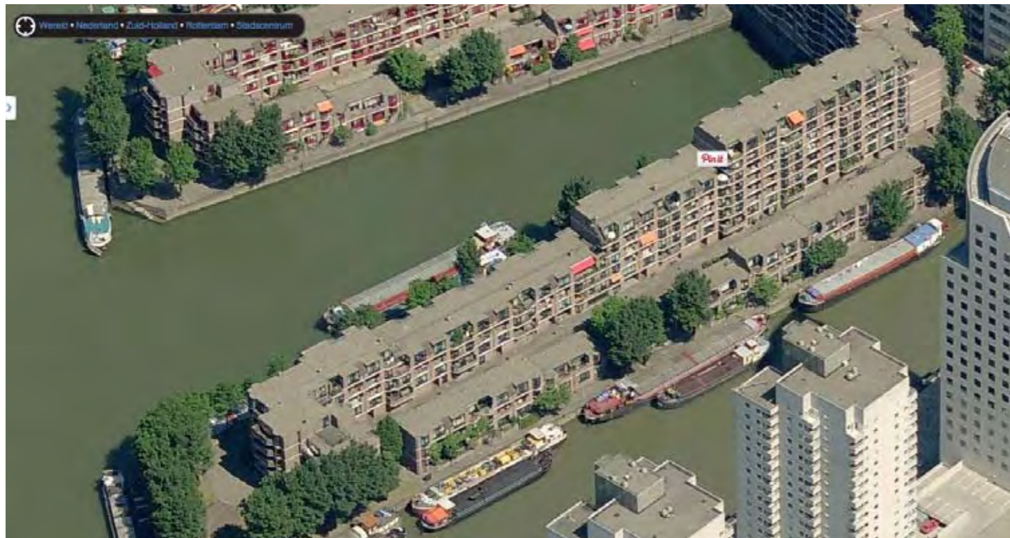
Aanzicht bestaande situatie Noordzijde
