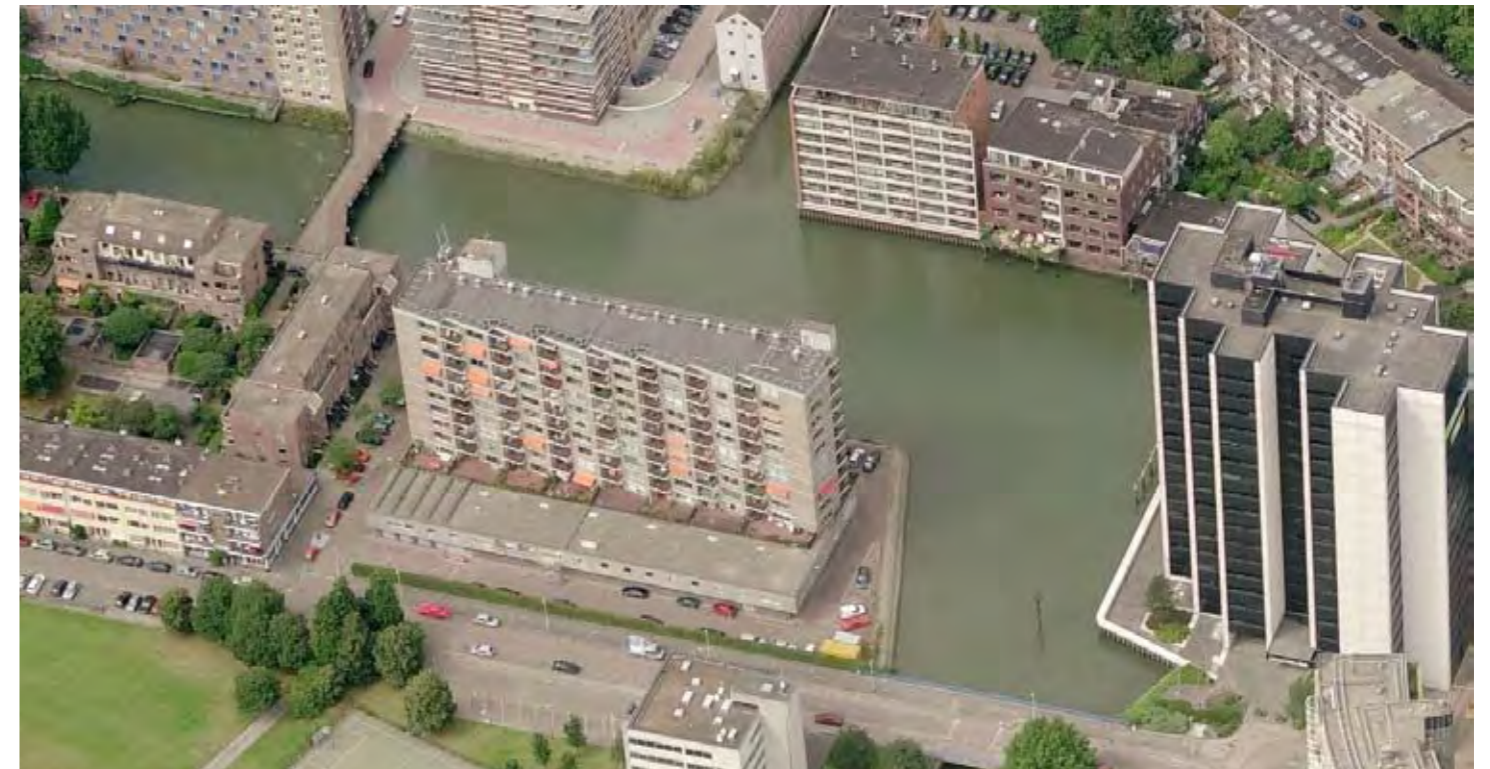
Aanzicht bestaande situatie Buizenwerf op Noordzijde
