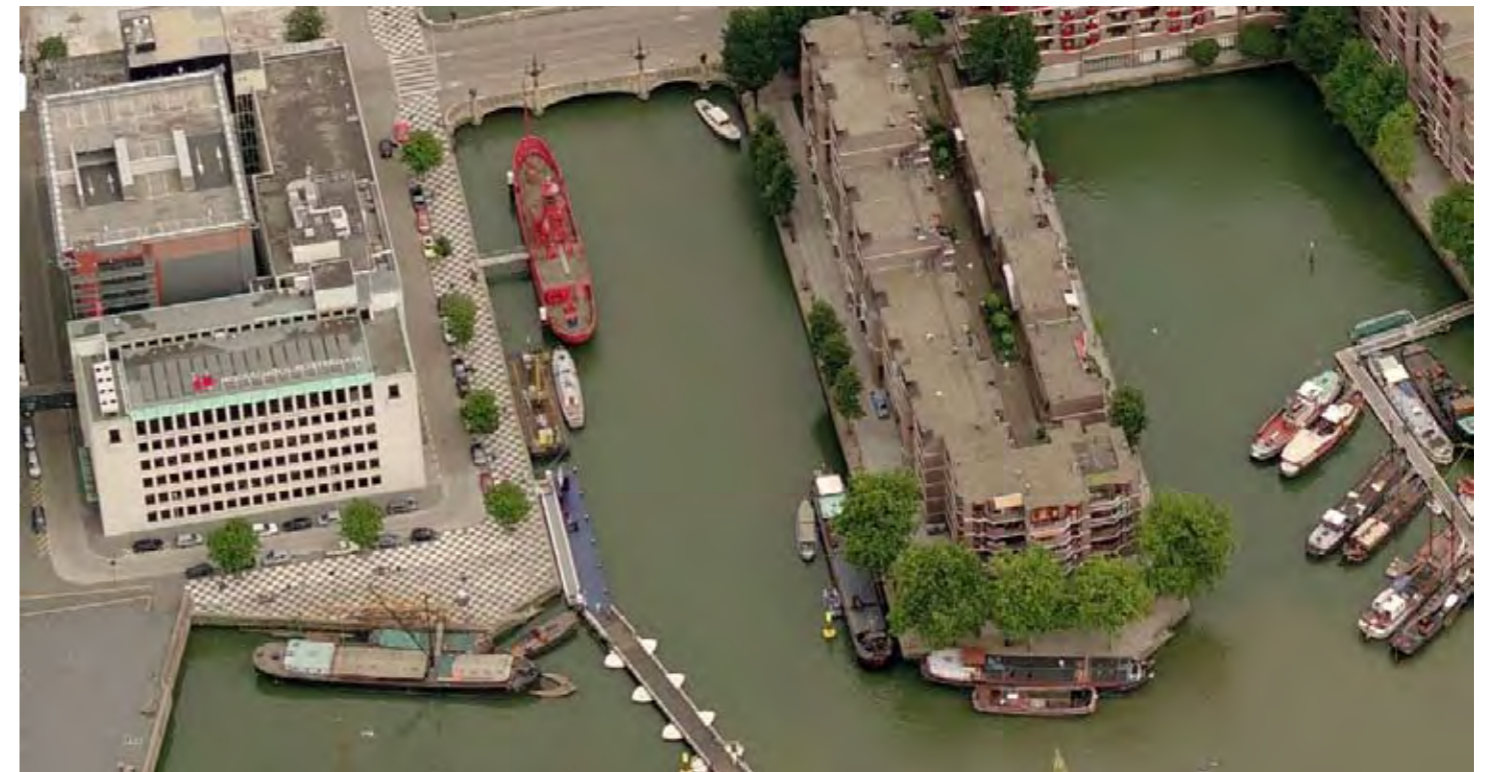
Aanzicht bestaande situatie vanaf west
