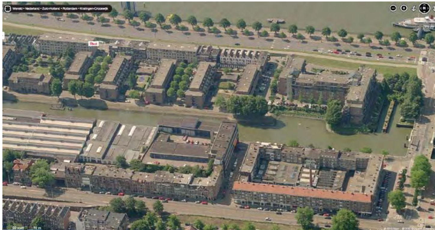
Aanzicht bestaande situatie vanaf Admiraliteitsbrug op Zuidzijde
